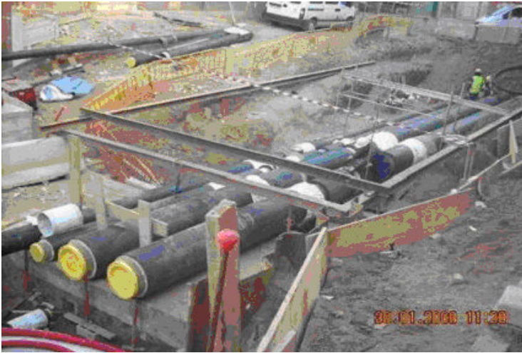
Disposición de canalizaciones en zanja
